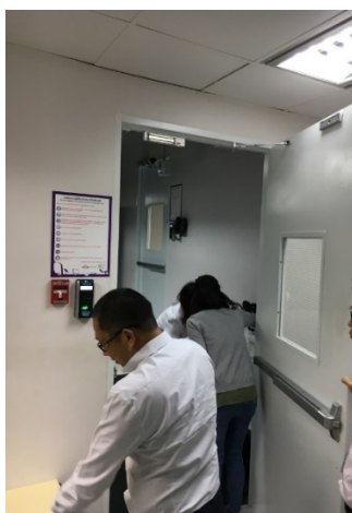
การ Access data center
