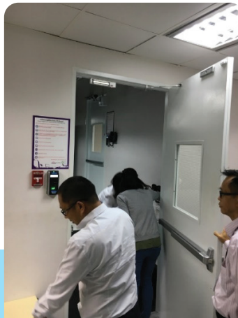
การ Access data center
